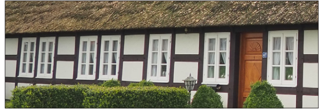
Abb. 58: Fenster in Fachwerkfassade
