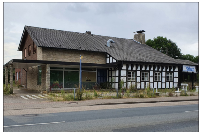
Abb. 41: Leerstand in ehemaligem Restaurant in Lembruch
