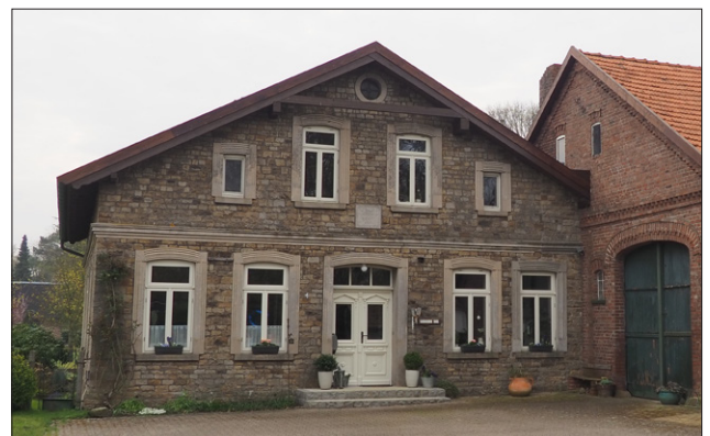
Abb. 57: Bruchsteinfassade
