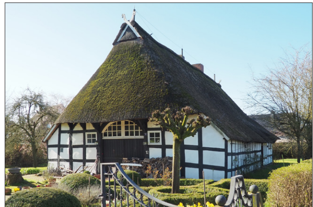
Abb. 44: Baudenkmal in Lembruch von 1623
