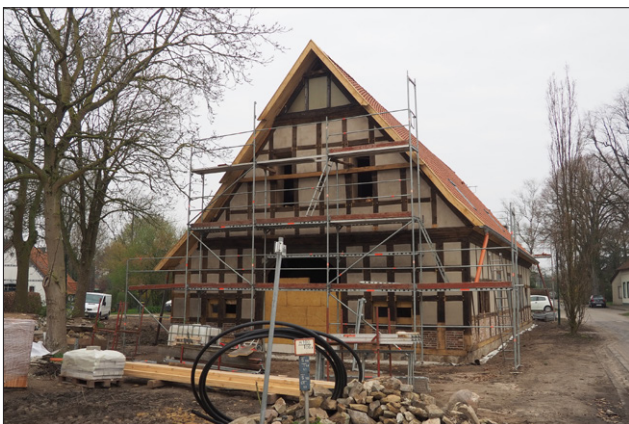
Abb. 43: Sanierung eines Fachwerkgebäudes in Marl
