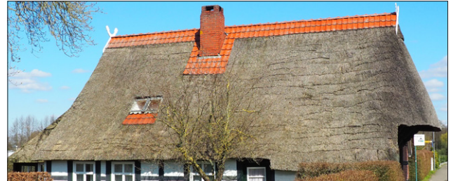
Abb. 54: Kombination aus Reet- und Tonziegeldach
