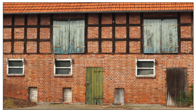
Abb. 59: Fenster und Türen im Wirtschaftsteil
