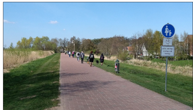
Abb. 27: Dümmerdeich bei Lembruch
