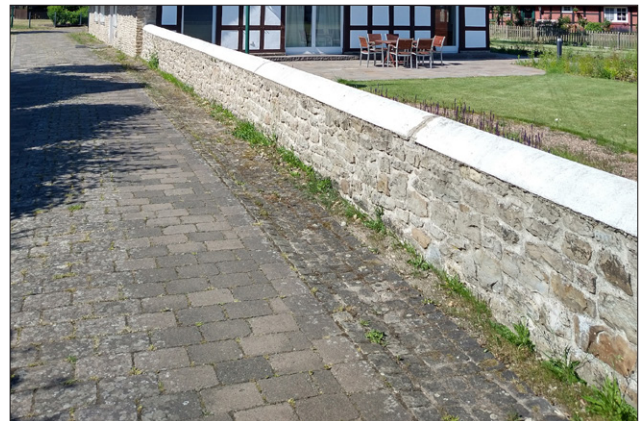
Abb. 65: Gerumpeltes Betonpflaster und Bruchsteinmauer
